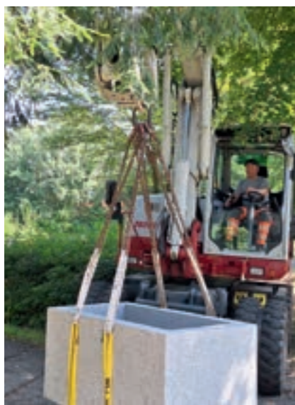
Montage der neuen Wassertröge im Friedhof
