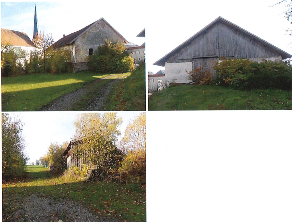
Abbildung 4: Relevante Gebäude im Plangebiet
